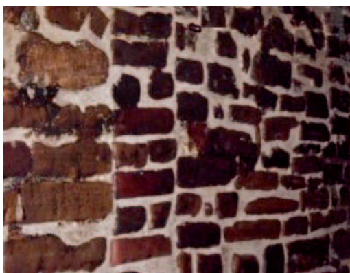
5. Detalle del muro de la Santa Casa de Loreto (Italia).
